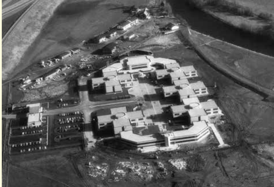
Abb. 3: Bauzustand im November 1980
